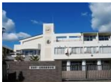
正門から見る校舎
